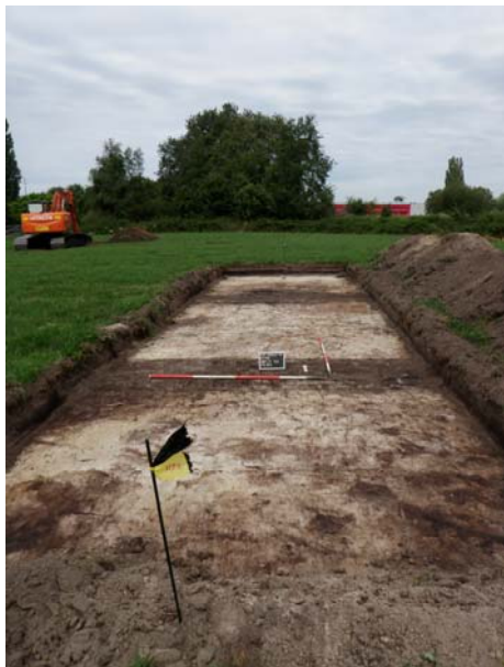
Figuur 12. Apeldoorn-RBAZ. Impressie van de aanleg van de proefsleuven.
